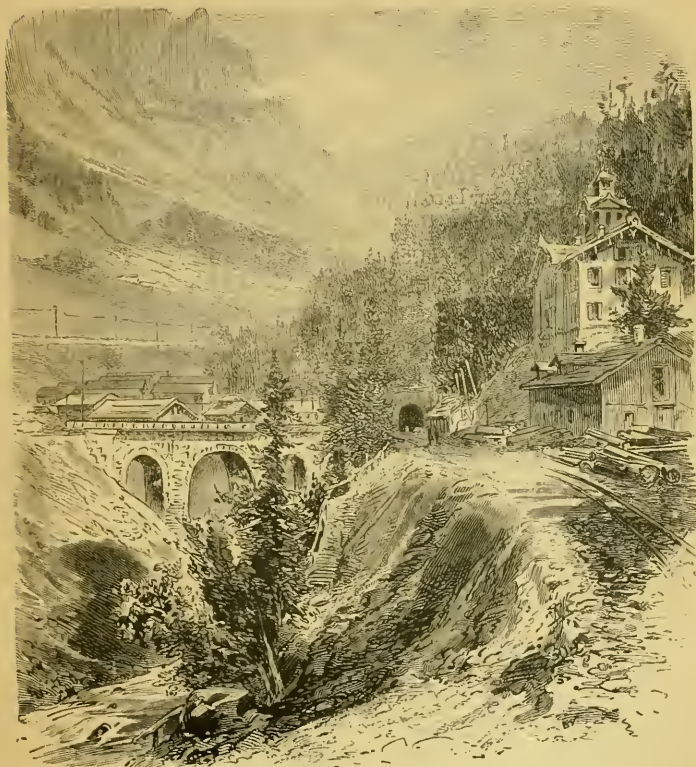
FIG. 123. — LANGEN (CÔTÉ OUEST DE L'ARLBERG)
